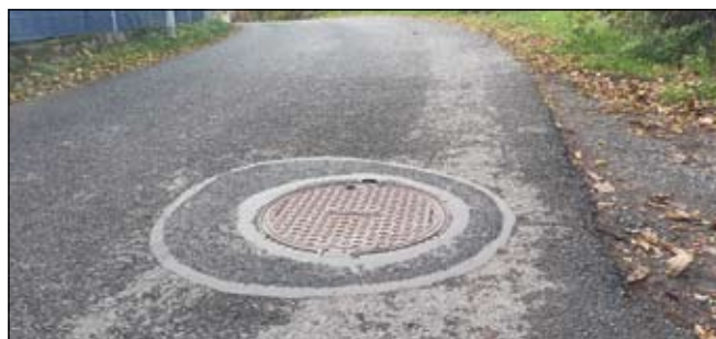
Nové poklopy v ulicích Za Cihelnou, K Cihelně a U Potoka
