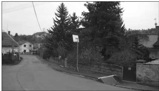
Pochodný kryt vodoteče ve Státnické ulici
