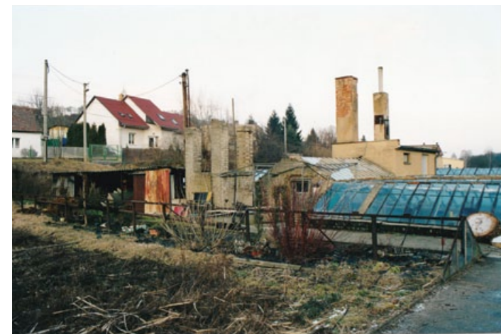
Areál v Černém Vole byl před tím, než sem přišla společnost Trees, v silně zanedbaném stavu.
