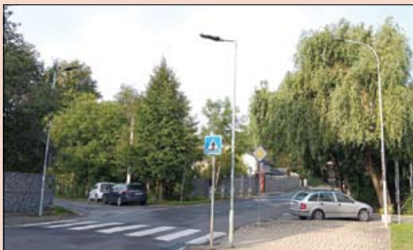
Výměna svítidel veřejného osvětlení
