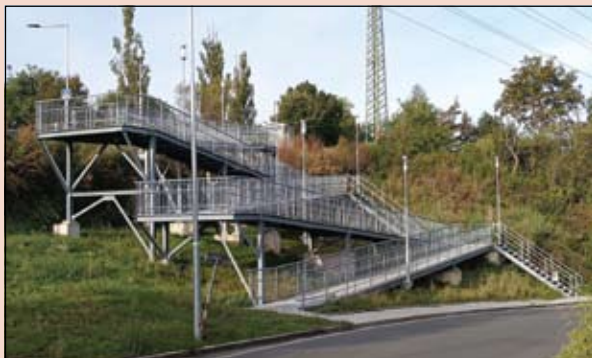
Chodník III. a IV. etapa – bezbariérová rampa
