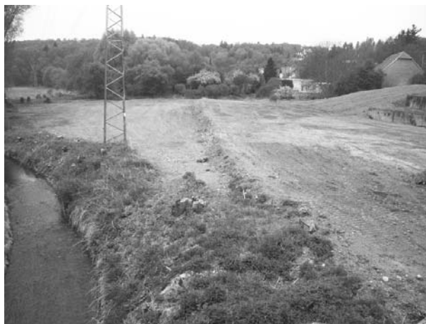
Zde je jasně patrné vytyčení záplavového území valem z hlíny přibližně uprostřed fotografie. Tím se otevřel prostor pro stavbu budovy školky navazující na linii teras Parádnice.
