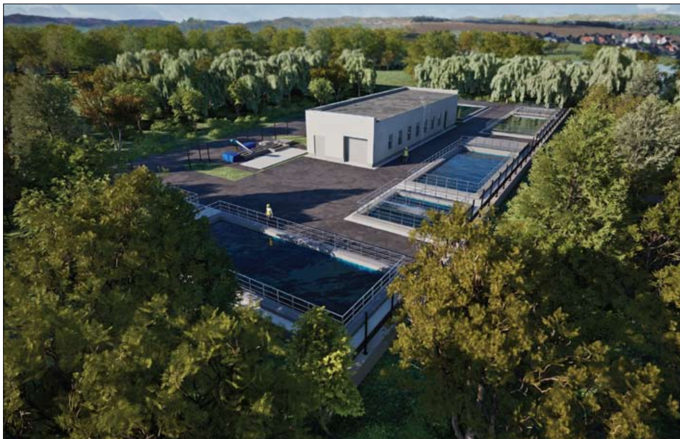
Čistička odpadních vod
