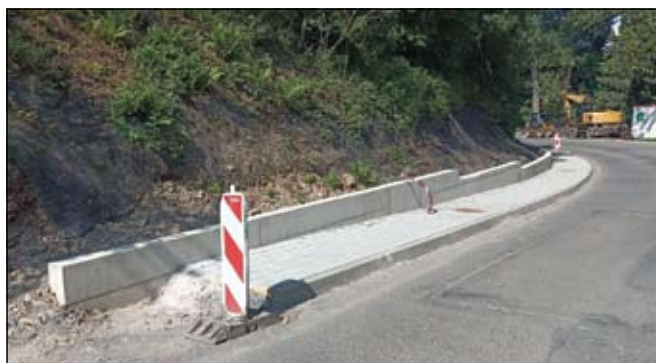
Na některých úsecích je již chodník hotový (foto: Jitka Lenková)
