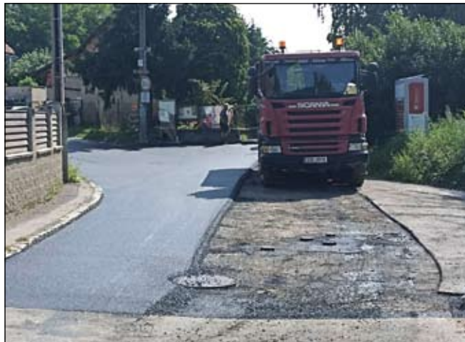
Vozovka na křižovatce ulic Skalní a Únětická během opravy 12. 6. 2025 (foto: Jitka Lenková)
