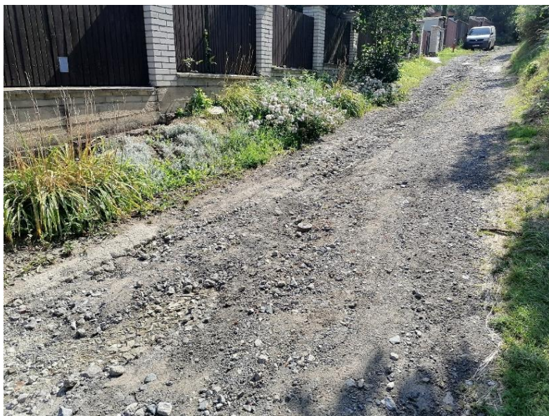
Obrázek 34 – Nevyhovující technický stav povrchu cyklotrasy 0077 v ulici Pod Punčochou
